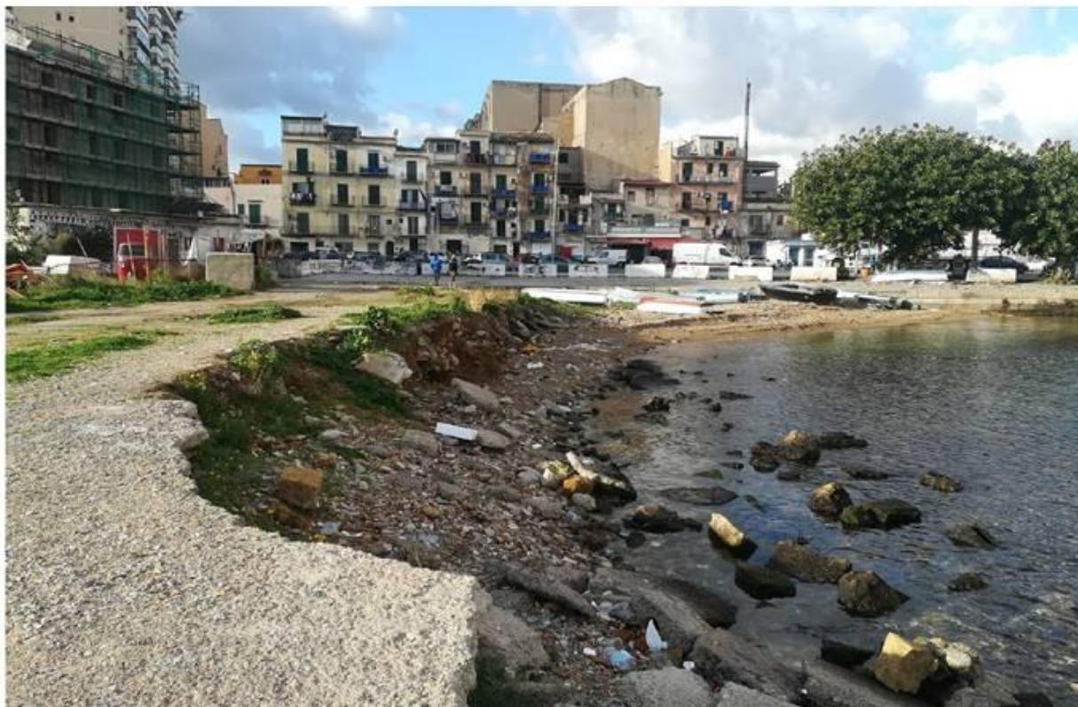
**Figura 13. Vista lato terra dell'evidente stato di degrado della banchina lato sud e della camminata che porta alla "picca a mare"**
